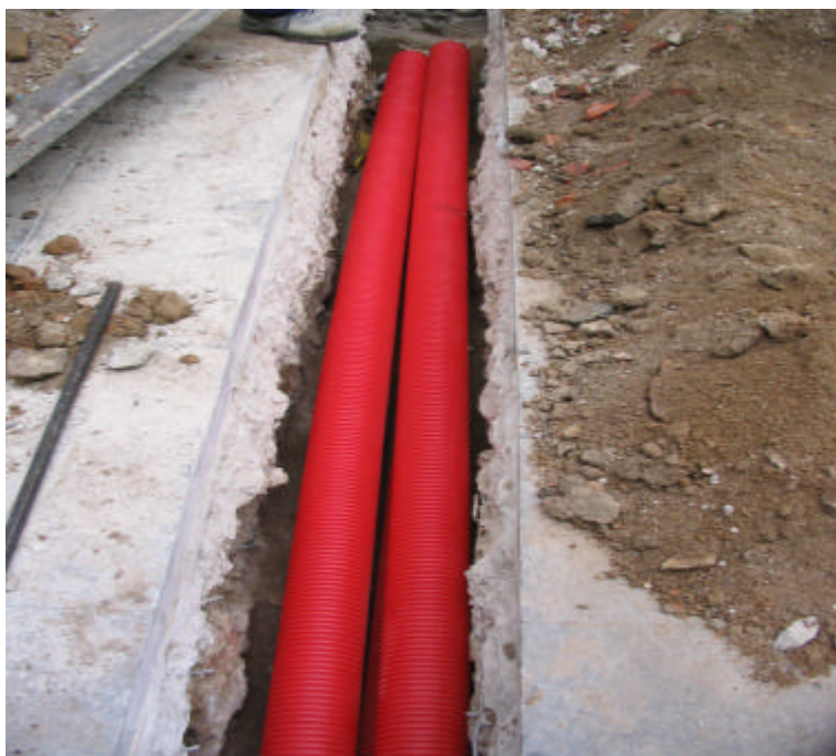
Fotografia núm. 2: Disposició dels tubs a la rasa
